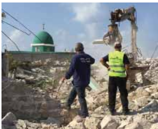
أعمال الحفريات ملاصقة لمسجد البرج
